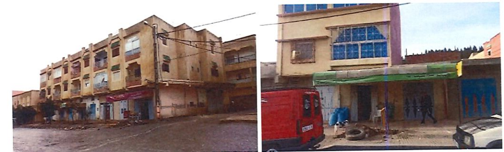
Maisons marocaines d'une qualité architecturale médiocre, aggravée par des RDC commerciaux accueillant des activités polluantes.
